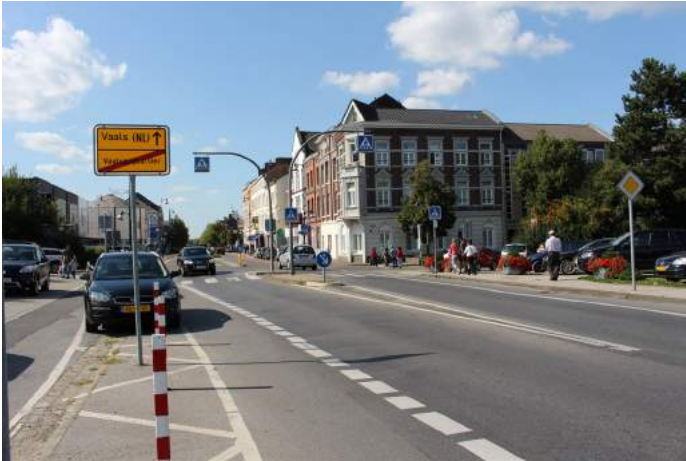
Blick von Südosten Richtung Vaals.
